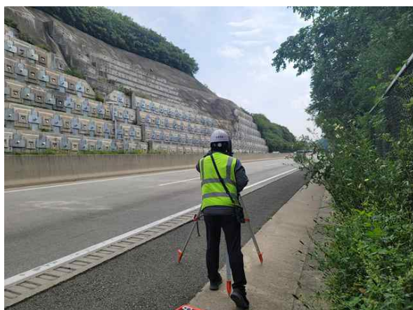
광파기를 이용한 측량 작업
