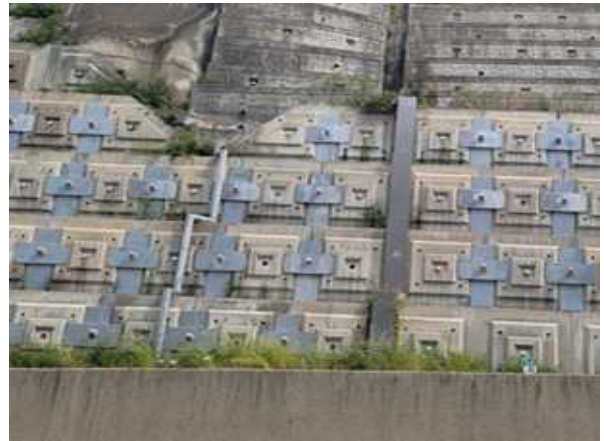
배수관, 배수로 전경
